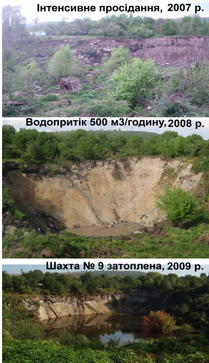
Рис. 14. Динаміка провалоутворення в районі Чорного Мочара внаслідок катастрофічного водопритоку в шахту № 9 у 2007–2009 роках із формуванням карстового провалу та карстового озера
