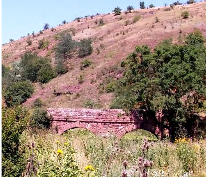
Рис. 12. Міст на замковій дорозі через р. Джурин.
