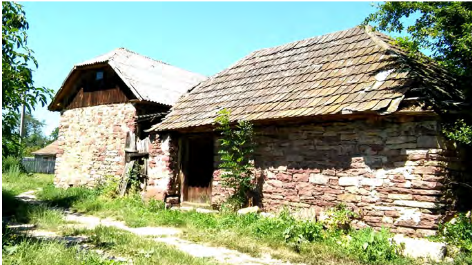
Рис. 13. Господарські будівлі (с. Нирків).
