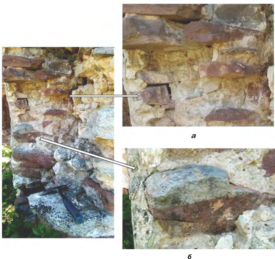
Рис. 8 . Фрагмент стіни палацу (урочище Червоне): a – ламані плити пісковик у різного розміру та забарвлення; б – різнозабарвлений пісковик у стіні палацу.
