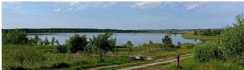
Рис. 5. Загальний вид на східну частину секції № 1 хвостосховища Стебницького ГХП «Полімінерал», повністю заповненою рідкою фазою
