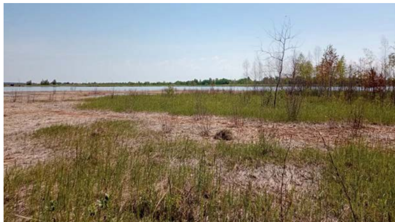
Рис. 6. Загальний вид на південну частину секції № 1 хвостосховища Стебницького ГХП «Полімінерал» на ділянці пляжу, де тверда фаза виходить на поверхню
