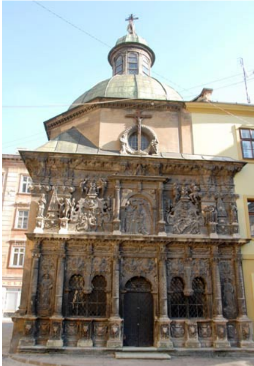
Рис. 1. Загальний вигляд фасадної стіни каплиці Боїмів
