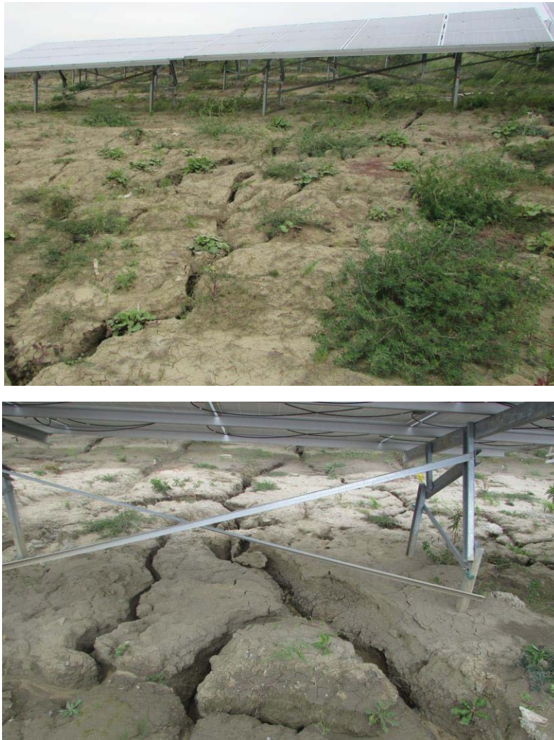
Рис. 8. Зростання інтенсивності приповерхневої лінійної ерозії від ледь заглибленої (вгорі) до досить заглибленої (внизу)
