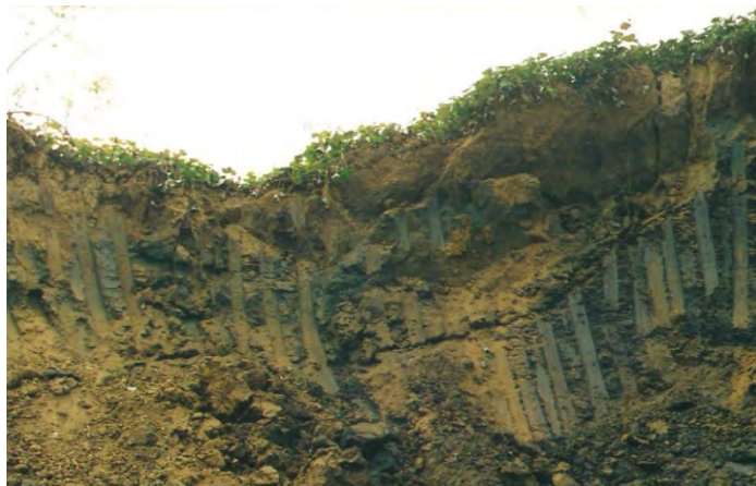
Рис. 5. Осувне зміщення глин в будівельному котловані (вул. Роксоляни)
