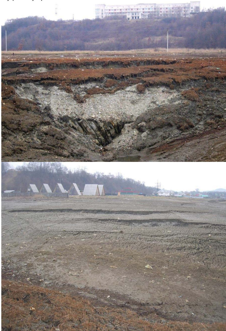
Рис. 8. Осушення майже усіх Солотвинських соляних озер в районі Затону після припинення водовідливу та затоплення шахти № 9 у січні 2009 р.
