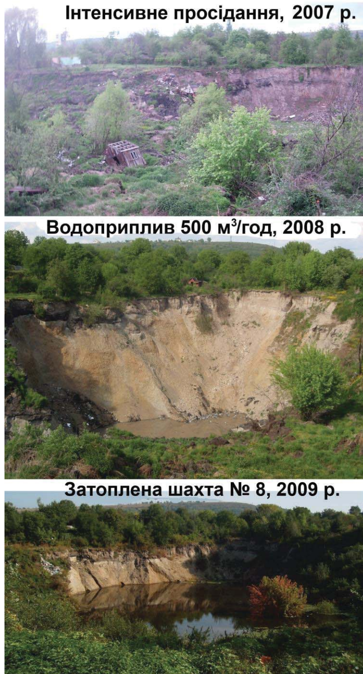
Рис. 7. Динаміка провалоутворення в районі Чорного Мочара внаслідок катастрофічного водоприпливу у шахту № 9 у 2007–2009 рр.
