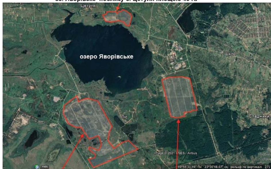
Сонячна електростанція на відвалі "Шоти" площею 175 га
