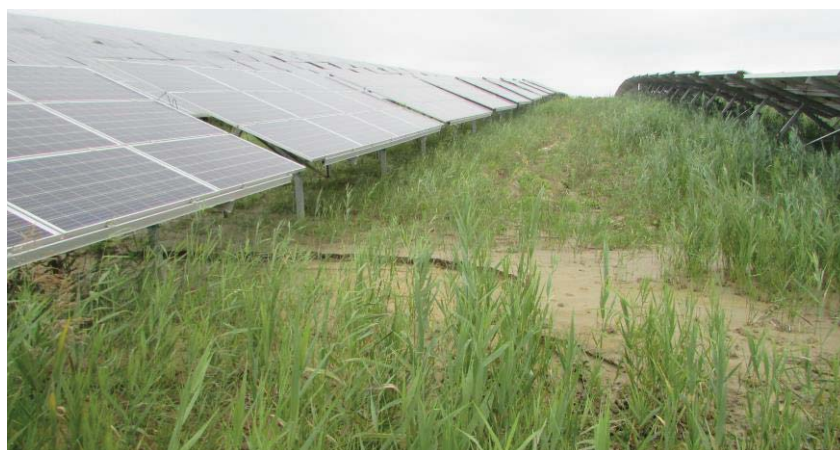
Рис. 7. Прояви точкового ерозійного розмиву концентрованими стоками зливових атмосферних опадів із сонячних панелей
