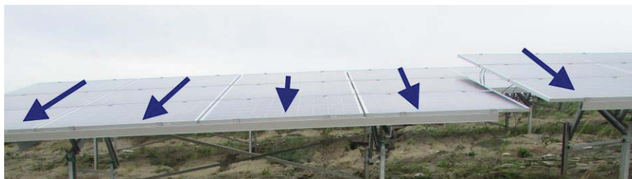
Рис. 6. Напрямки концентрованого стоку зливових атмосферних опадів у ґрунт
