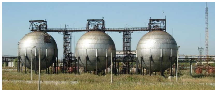
Рис. 3. Цистерни для зберігання сірчаної кислоти.
